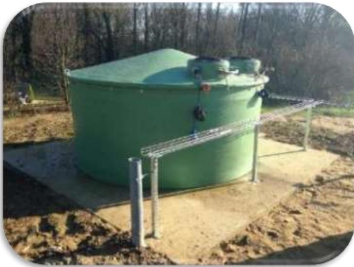
Cette installation, située à Guéreins, accueille les pulvérisateurs sur son aire bétonnée étanche. Ils sont nettoyés à haute pression et leurs effluents sont transférés temporairement vers une cuve tampon. A l'aide de 2 pompes, ils sont envoyés par aspersion sur un mélange terre-paille dans 2 cuves étanches : les phytobacs®. Comme dans le sol, les microorganismes dégradent progressivement les produits phytosanitaires sans aucun rejet vers le milieu naturel.
